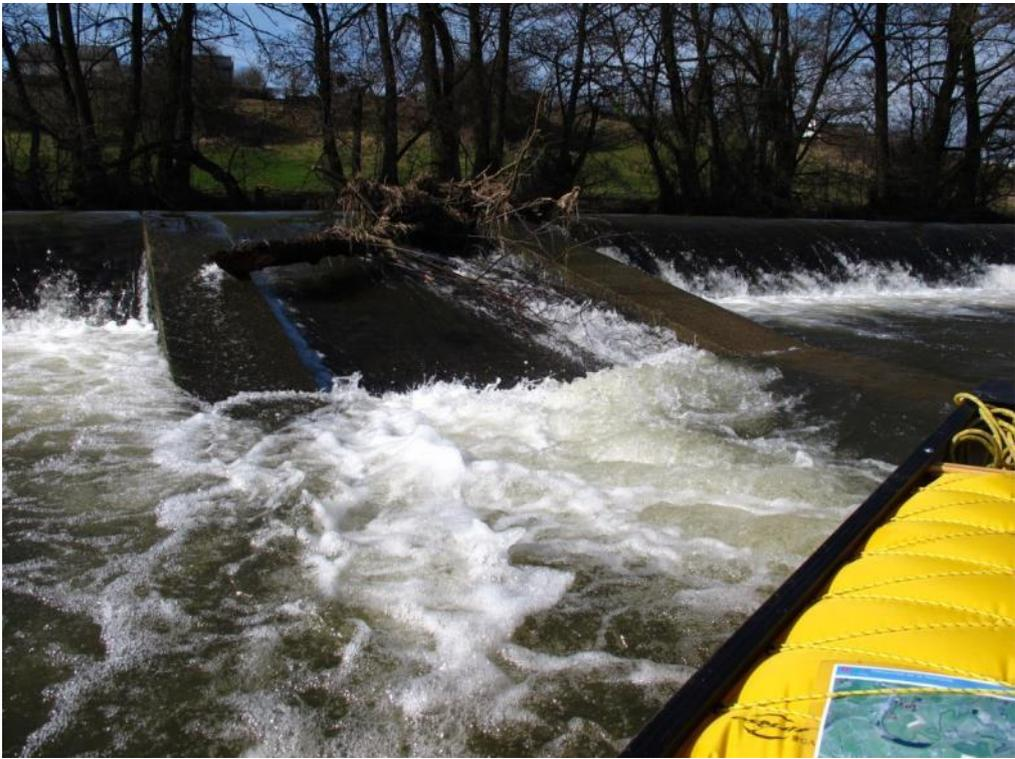
Photo 10 - Une passe aménagée n'est pas forcément praticable et le franchissement d'un barrage exige toujours un repérage. Ici, la passe est bouchée par un arbre abattu : danger ! (Semois, barrage de Termes, entre Tintigny et Chiny)
